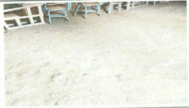
Foto 4: SE OBSERVA EL DETERIORO DEL PISO DEL ESTABLECIMIENTO
